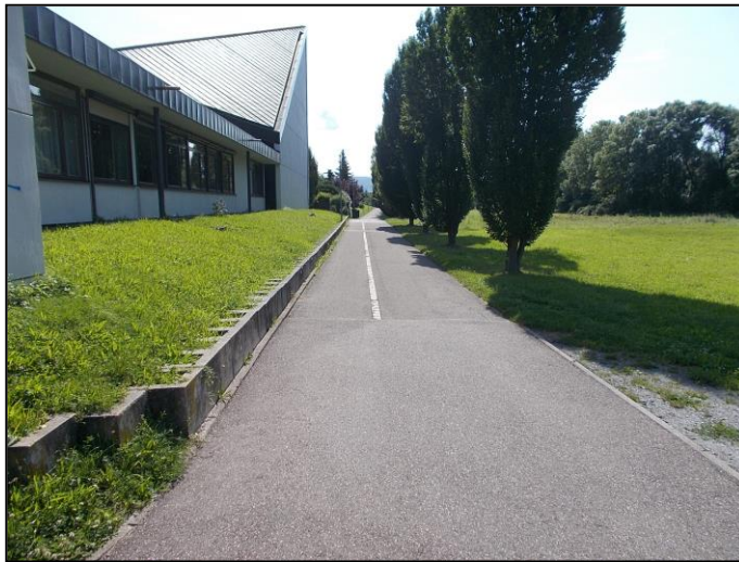
Abb. 09: getrennter Geh- und Radweg südlich Vaterunser-Kirche (Willsbach) (Quelle: Aufnahme BS Ingenieure)
