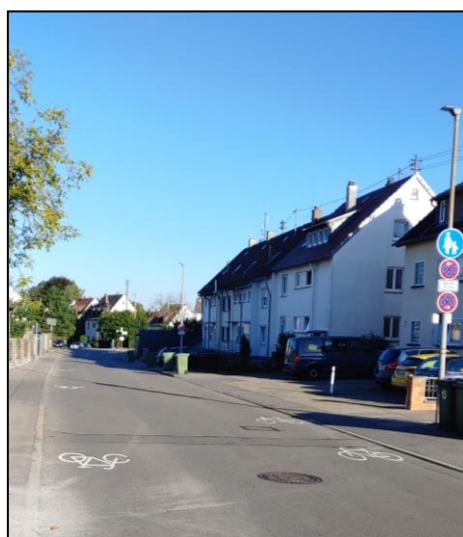
Abb. 15: Beispiel Piktogrammkette auf der Fahrbahn (Quelle: Aufnahme BS Ingenieure)
