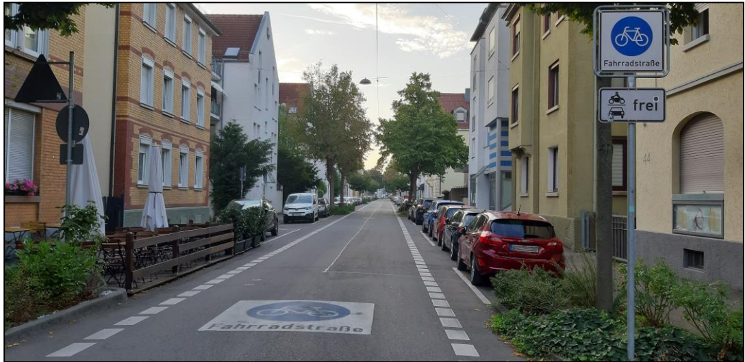
Abb. 14: Beispiel Fahrradstraße mit Freigabe für Kfz-Verkehr und Sicherheitstrennstreifen zum ruhenden Verkehr (Quelle: Aufnahme BS Ingenieure)
